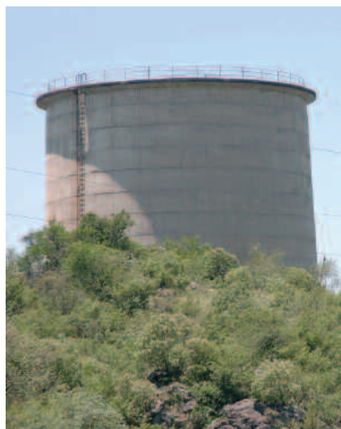
La torre de la chimenea de Los Molinos I vista desde su base.
