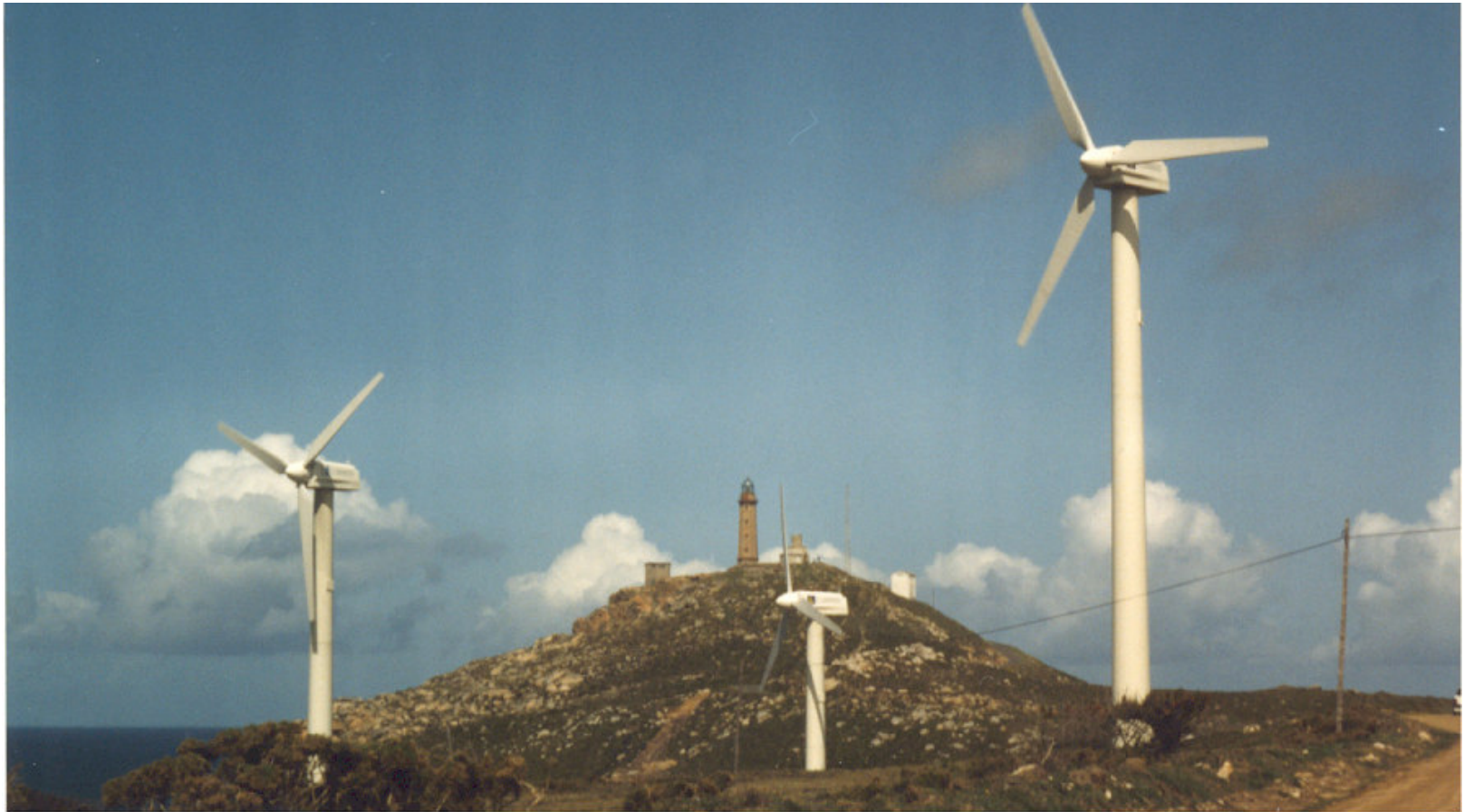
Parque eólico de Cabo Vilano
